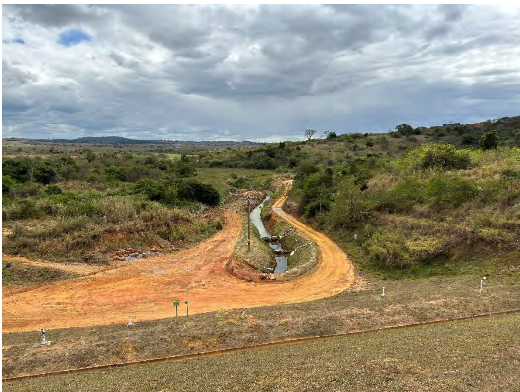
Foto 11 – Área de jusante – detalhe para o canal de drenagem do medidor de vazão.
