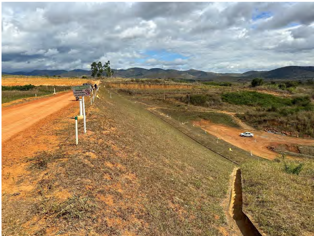
Foto 7 – Talude de jusante – vista para a ombreira esquerda.
