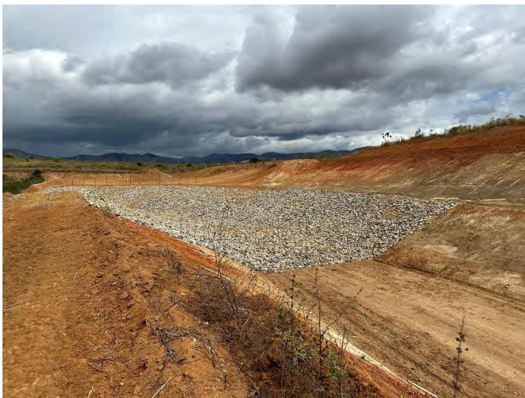
Foto 14 – Novo emboque do canal extravasor.
