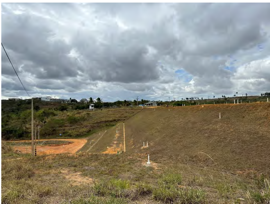
Foto 6 – Talude de jusante – vista para a ombreira direita.
