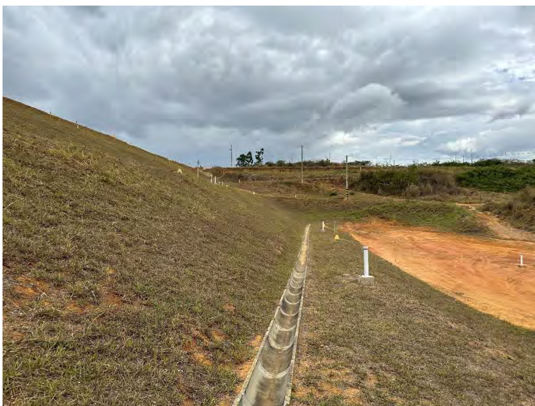
Foto 10 – Berma da cota 170 m (var.) – vista para a ombreira esquerda.
