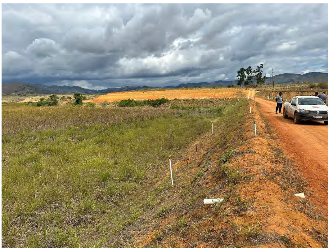
Foto 4 – Talude de montante – vista para a ombreira esquerda.
