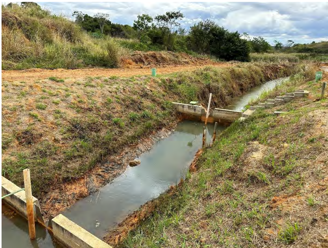
Foto 13 – Medidores de vazão.
