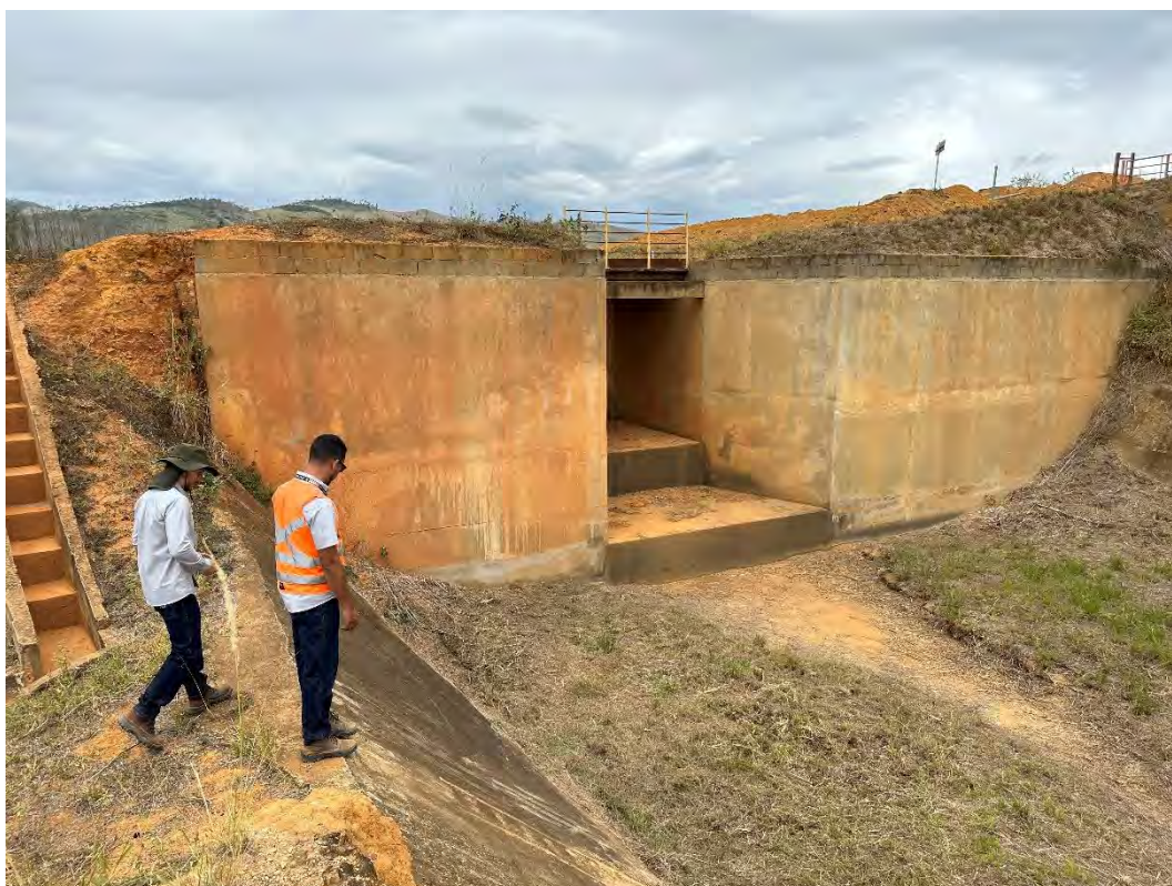
Foto 18 – Desemboque do extravasor – detalhe da soleira de concreto
