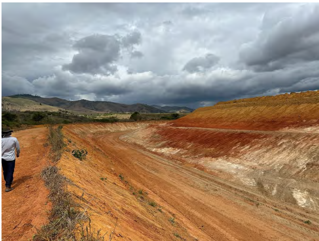
Foto 15 – Canal extravasor – Taludes reescavados, com inclinação que favorece a cobertura vegetal. Não há assoreamentos.
