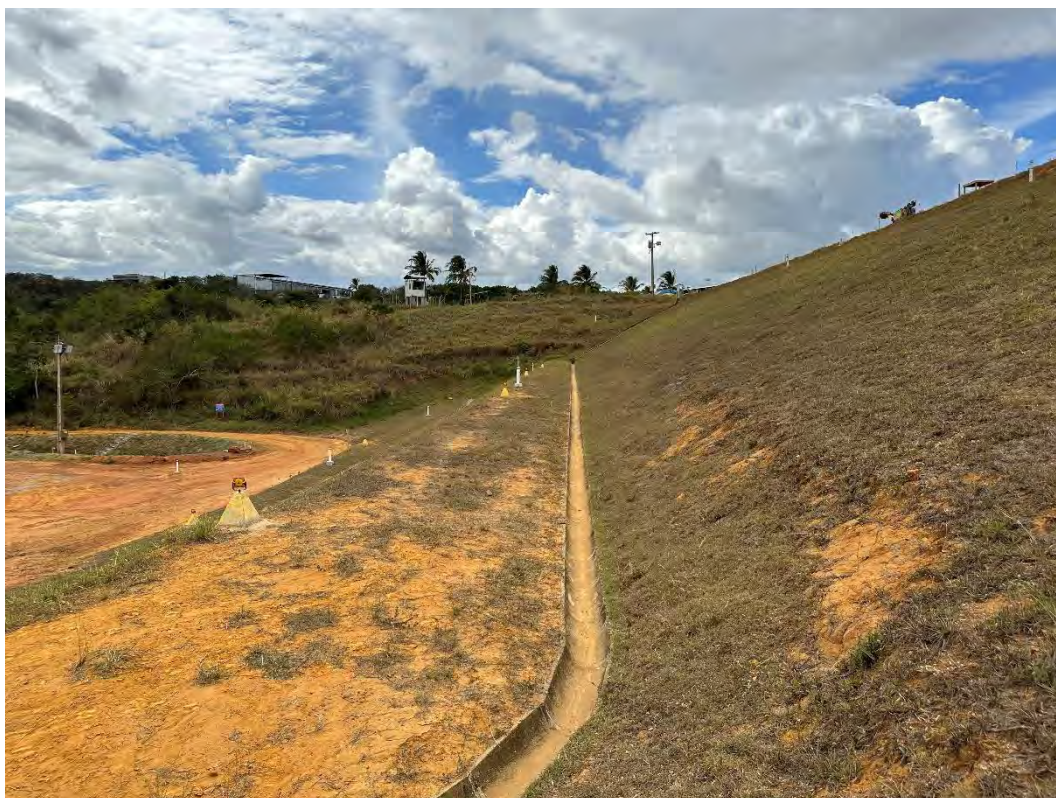
Foto 9 – Berma cota 175 m (var.) – Vista para a ombreira direita.
