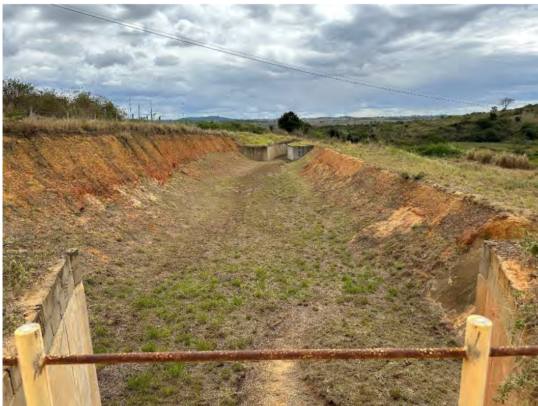
Foto 19 – Vista do canal do extravasor – vista para jusante
