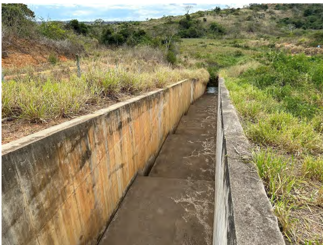
Foto 20 – Trecho do canal extravasor em concreto – Escada hidráulica.
