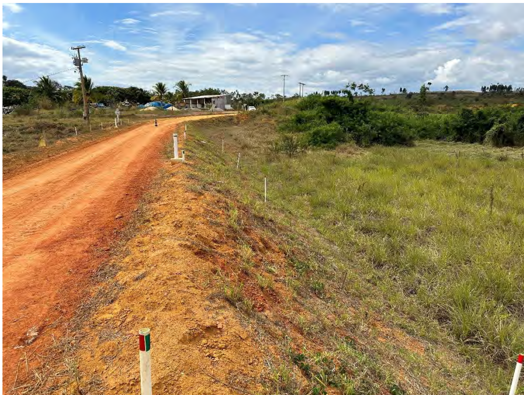
Foto 5 – Talude de montante – vista para a ombreira direita.
