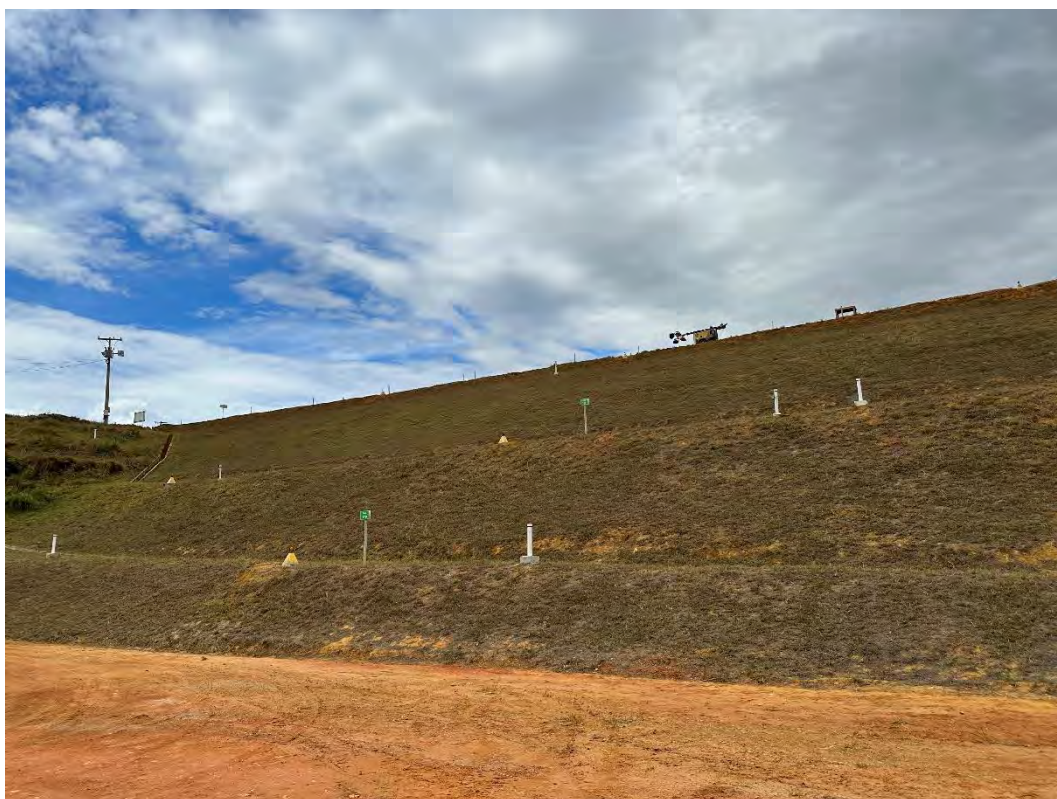
Foto 8 – Vista frontal do talude de jusante.
